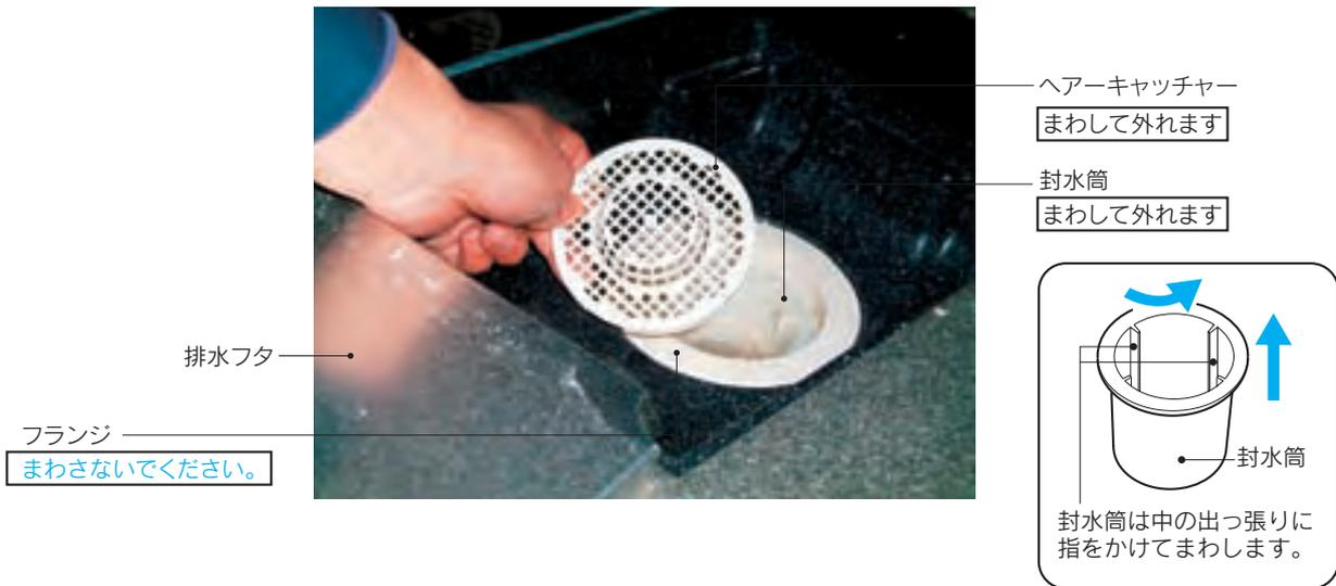
お掃除が終わったら、封水筒やヘアキャッチャー、排水フタを正しく取り付けてください。その後、トラップ内に封水をためるために洗面器1杯くらいの水を流してください。
